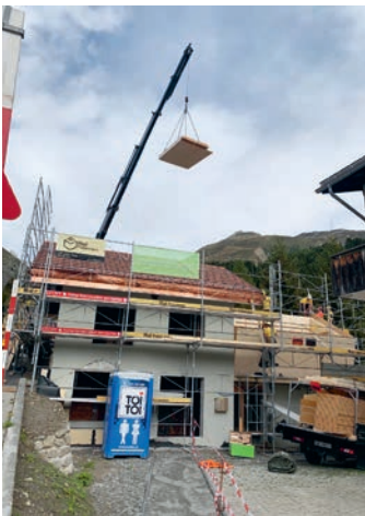
La construcziun dil baghetg annex
