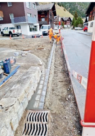
Via Cantunala: Adattaziun dall'entrada dalla Via dil Bogn
