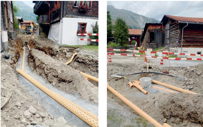
Drenadi e separaziun dalla aua da meteo e fecalias
