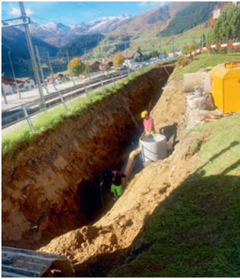
Foss per la canalisaziun / aua piarsa e conduct d'aua a Salins
