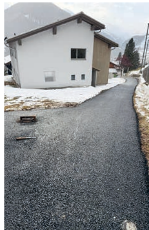
Senda reconstruida ed asfaltada
