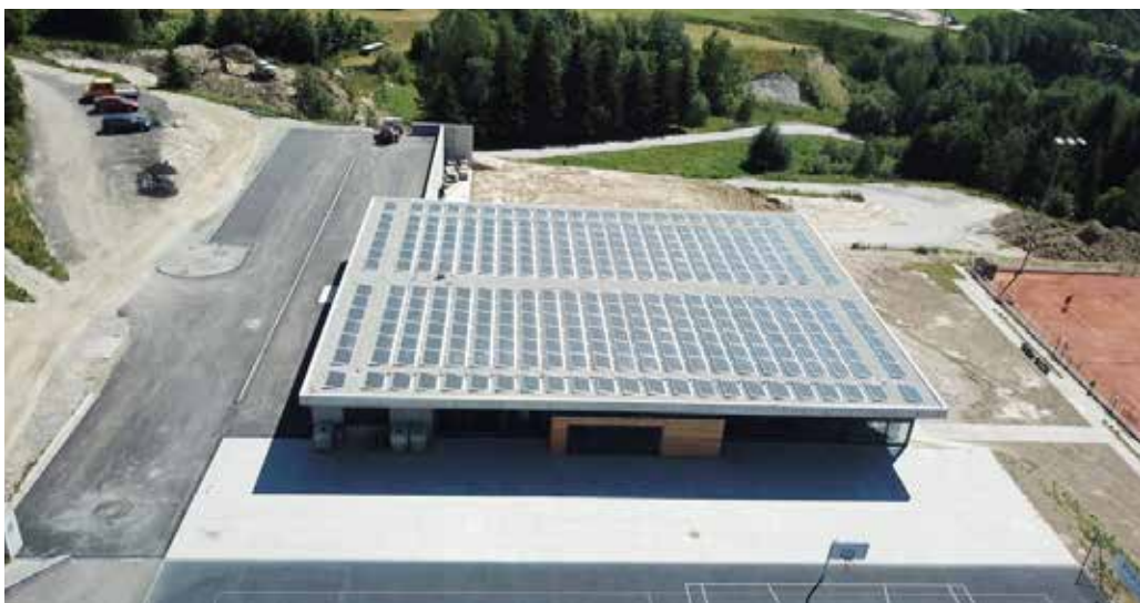
Indrez fotovoltaic halla plurivalenta Dulezi
