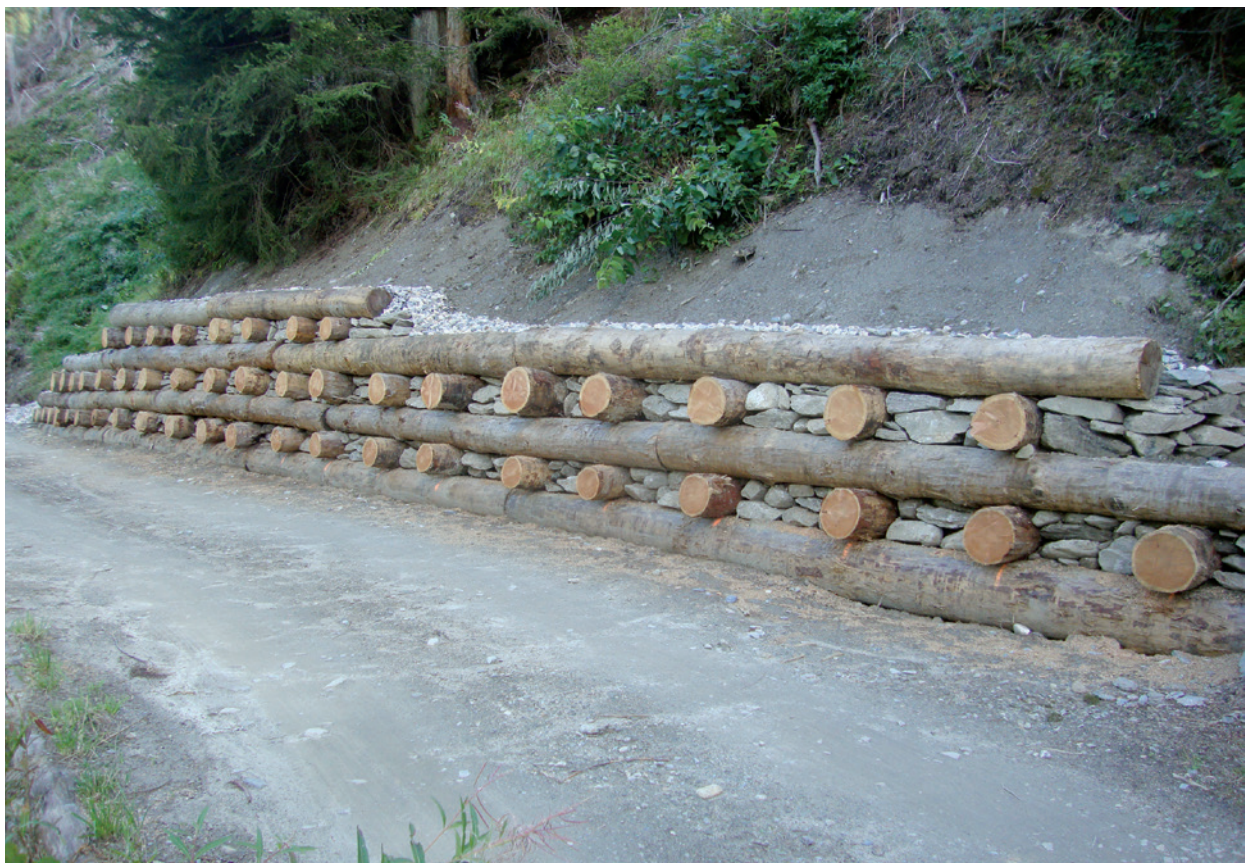
Cumbinaziun da buoras e crappa per la construcziun dils murs da sustegn
