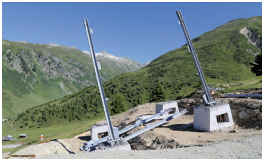
Lavurs da construcziun dalla nova pendiculara Salins - Cuolm da Vi
