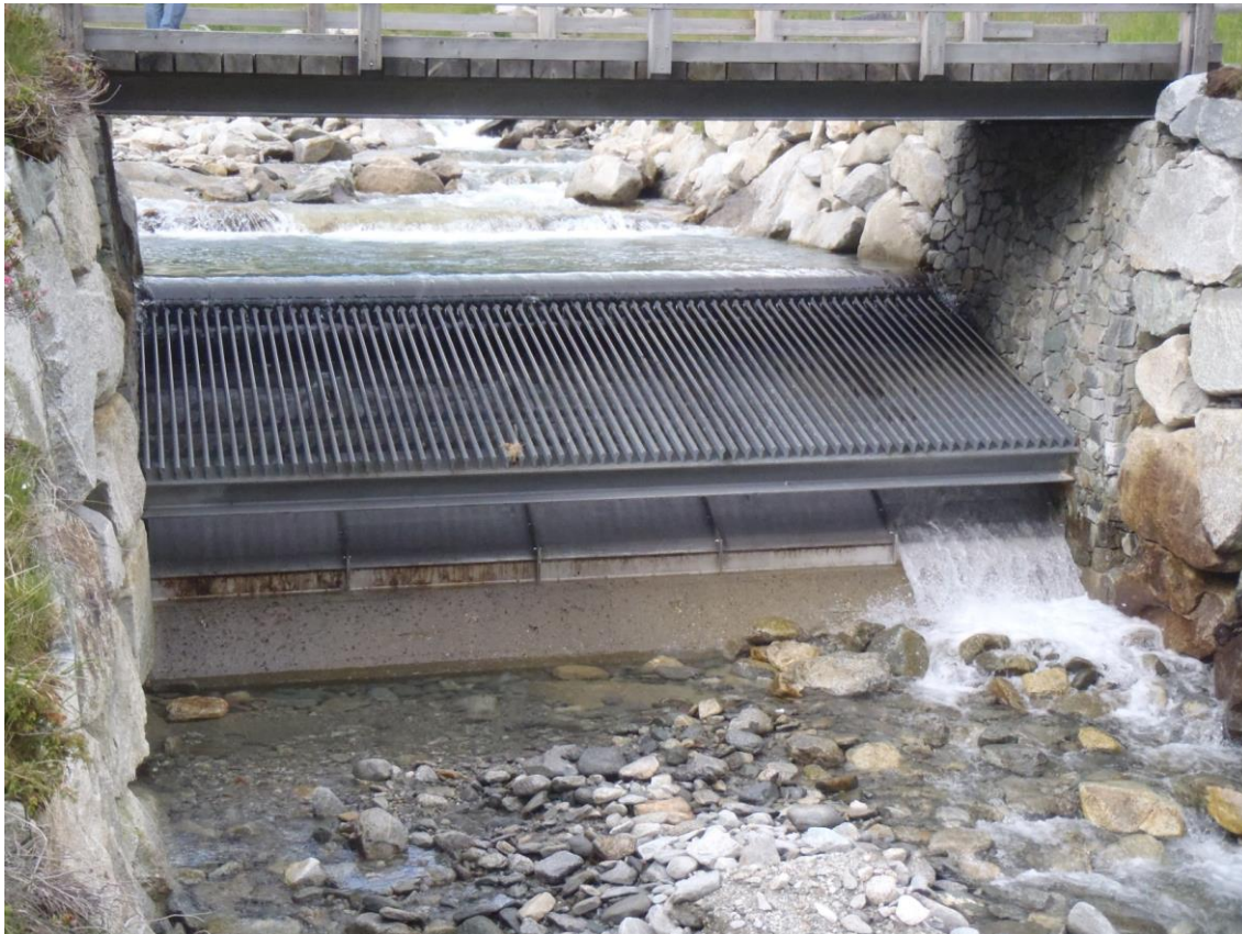
foto 4: exempel d'in risti coanda cun risti grop e dretg il scul dall'aua restonta
