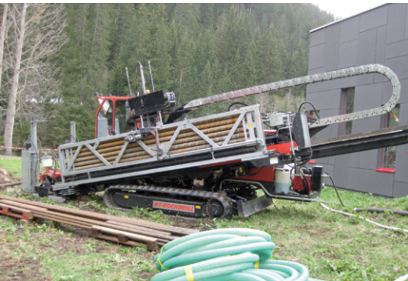
Erecciun dalla nova lingia da canalisaziun
