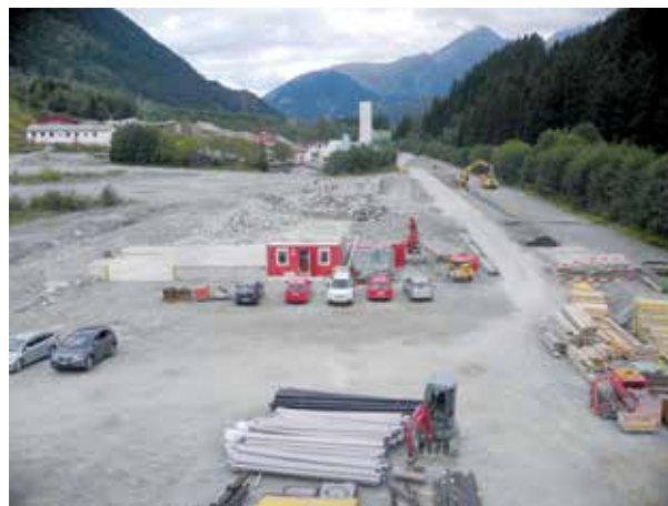
La piazza d'installaziun vegn renaturalisada.
