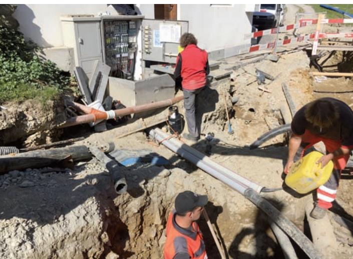
Sanaziun dalla via Zarcuns
